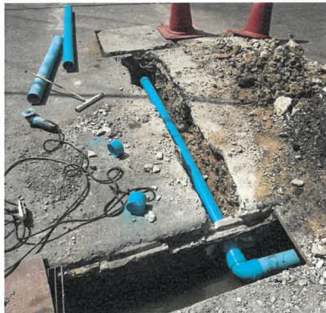
รูปที่ 3.3-18 แสดงการต่อท่อน้ำทิ้งจากถังบำบัดน้ำเสียของโครงการ เข้าสู่ระบบบำบัดน้ำเสียรวมของโรงพยาบาลพระมงกุฎเกล้า
